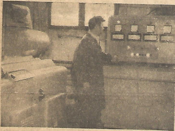
A fröccsöntő automata vezérlőszekrénye
